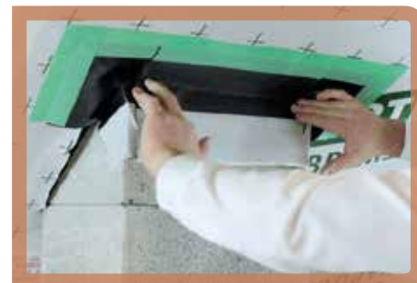
Vnitřní rohy s podomítkovou úpravou
